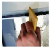
2.: Fuge von oben mit Spezialdichtstoff gut füllen! Reste mit Silikonspachtel abziehen.
